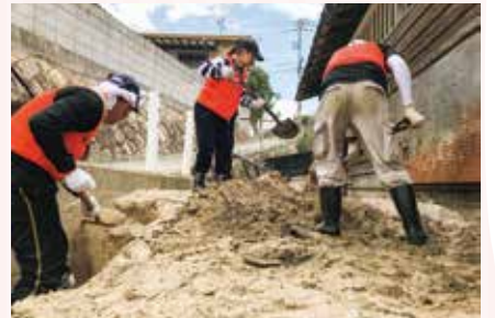
「平成30年7月豪雨」の復興支援として土砂撤去作業を行う学生たち
